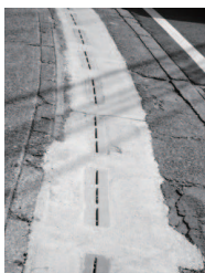
左..改良工事された U字溝
