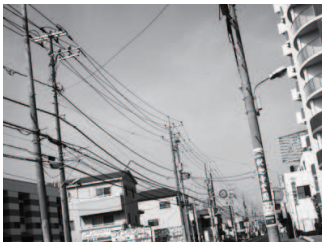
上..電柱移転工事、 やっと進む
